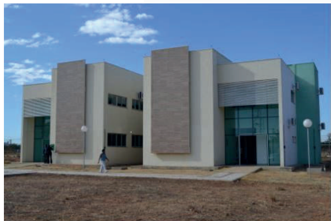
Prédio tem mais de 700 metros quadrados de área construída (Foto: Samuel Lima/Dicom)
